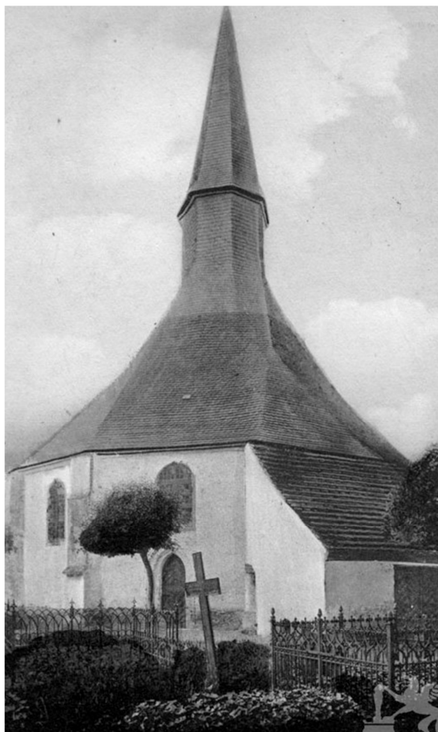
Ryc. 9. Darłowo, kaplica św. Gertrudy, okna o podziale szybkami prostokątnymi, stan sprzed 1945 roku. Zdjęcie ze zbiorów J. Buziałkowskiego
